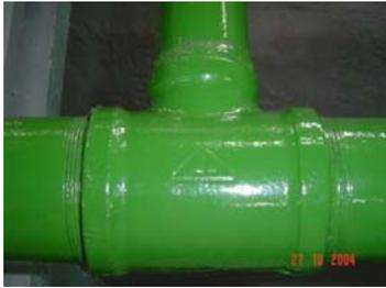
$L_{eq26} = 0,34 \text{ m}$  - EQUIVALÊNCIA DA PERDA DE CARGA DAS CONEXÕES TUPY BSP EM METROS DE TUBOS DE AÇO GALVANIZADO – página 76.
