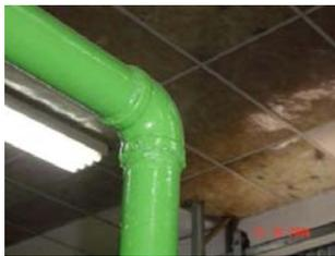
$L_{eq17}$  - = **1,88 m** - fonte de consulta: EQUIVALÊNCIA DA PERDA DE CARGA DAS CONEXÕES TUPY BSP EM METROS DE TUBOS DE AÇO GALVANIZADO – página 76;
