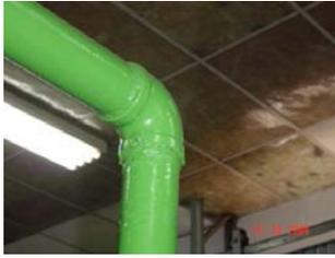
$L_{eq15}$  - = **1,88 m** - EQUIVALÊNCIA DA PERDA DE CARGA DAS CONEXÕES TUPY BSP EM METROS DE TUBOS DE AÇO GALVANIZADO – página 76;
